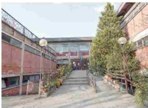
La media Enrico Fermi È stata progettata nel 1961 e costruita negli anni seguenti. Oggi segna il passo in termini di funzionalità pur essendo perfettamente a norma
